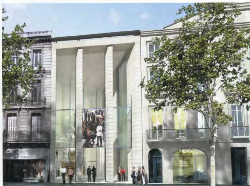
Vue de l'entrée générale - Document © 4a-architectes
