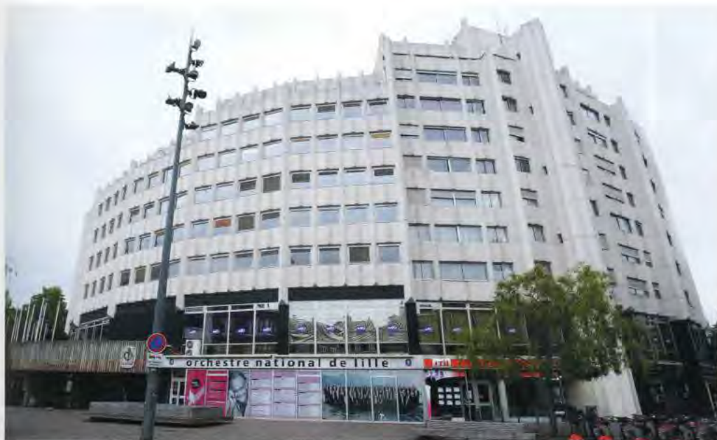
Vue extérieure, entrée - Photo © Services techniques du Palais du Nouveau Siècle
