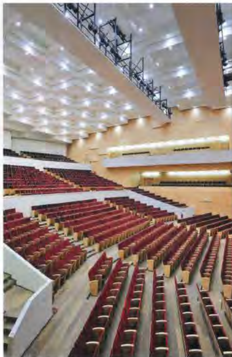
Réseau de passerelles salle au-dessus du parterre ; distribution en salle
